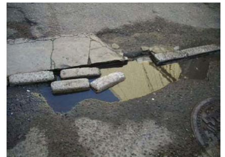
▲ 縁石の剥がれ
