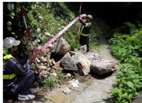
▲石積端部が崩落して道を塞ぐ
