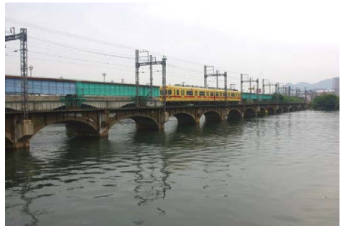
▲名島川橋梁(大正12年完成)
