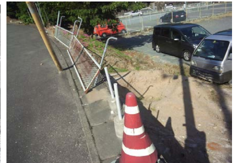
▲ 防護柵の欠損
