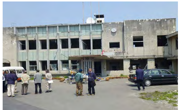
▲大槌町役場の被災状況
