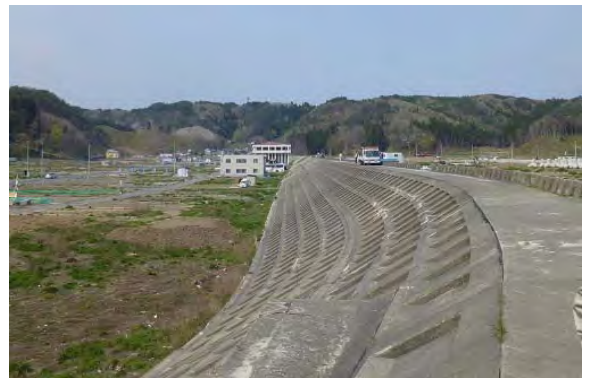
▲田老地区防潮堤
